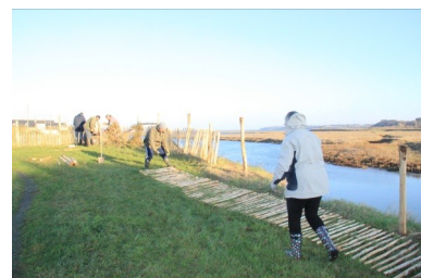
Chantier sur le bord de la réserve naturelle
