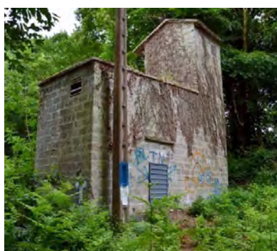
Réhabilitation du transformateur à Plancoët. Photo de Yves Faguet
