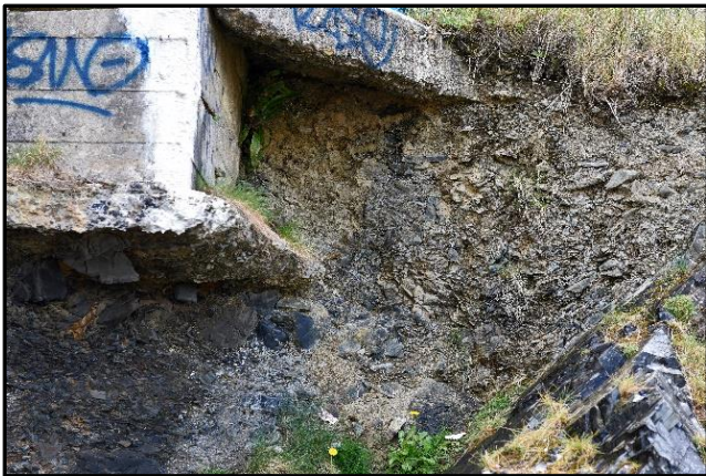
Fig.56 Recul de la falaise rocheuse sous le blockhaus (YG)
