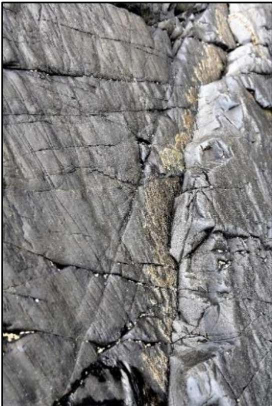
Fig.70 Glissement avec silice (quartz), entre les bancs (YG)
