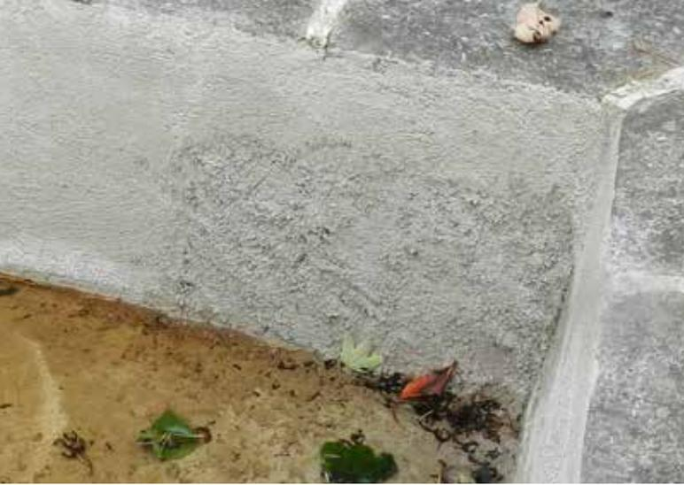
Pente douce et enduit gratté pour permettre la sortie de la faune
