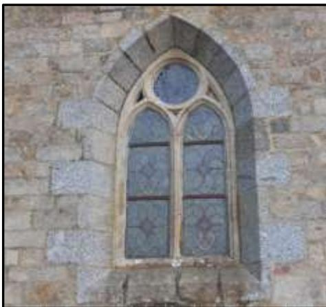
Fig.31 église de Pluzunet, murs en granite ocre et fenêtre à encadrement en granodiorite de Bégard (Photo GM)
