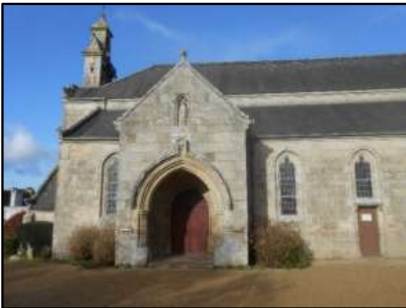
Fig. 49 Trégrom, Eglise de Saint Brandan
