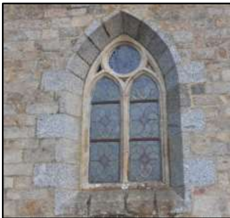
Fig.31 église de Pluzunet, murs en granite ocre et fenêtrage à encadrement en granodiorite de Bégard
