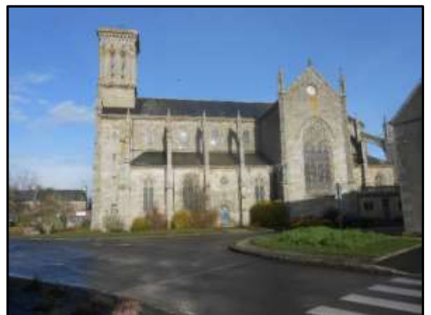
Fig. 47 le Vieux-Marché, Eglise Notre Dame de la Consolation
