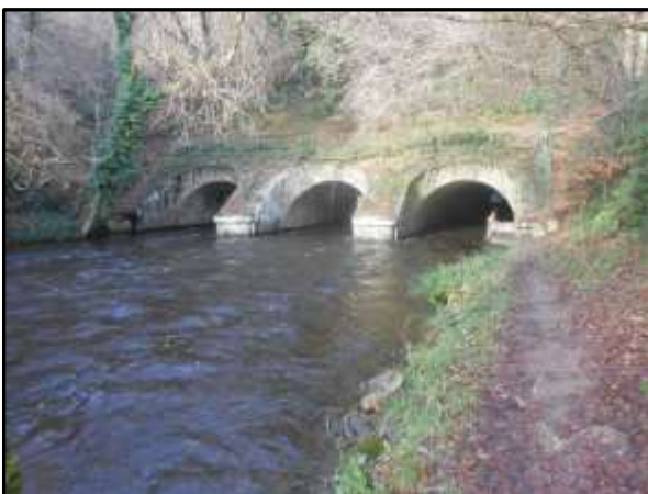
Fig. 50 Pont Tunnel de Kervod sur le Léguer
