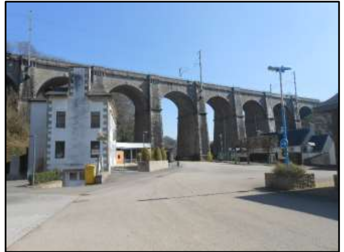
Fig. 93 viaduc ferroviaire du Ponthou
