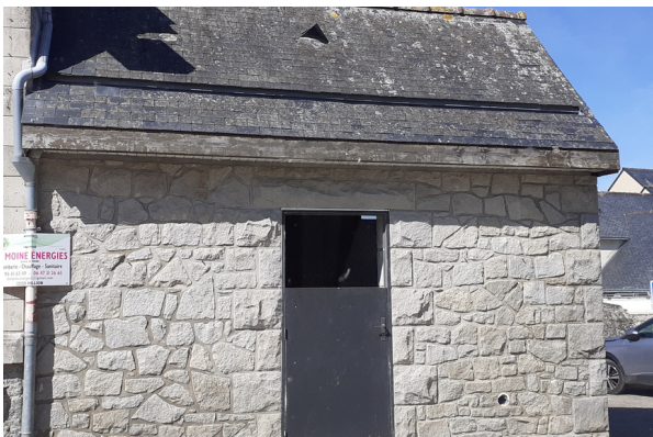
Toilettes publiques à Hillion : suite au signalement d'un bénévole, la porte posée dans le cadre de la rénovation des toilettes a été sciée pour permettre à nouveau l'installation des hirondelles rustiques.
