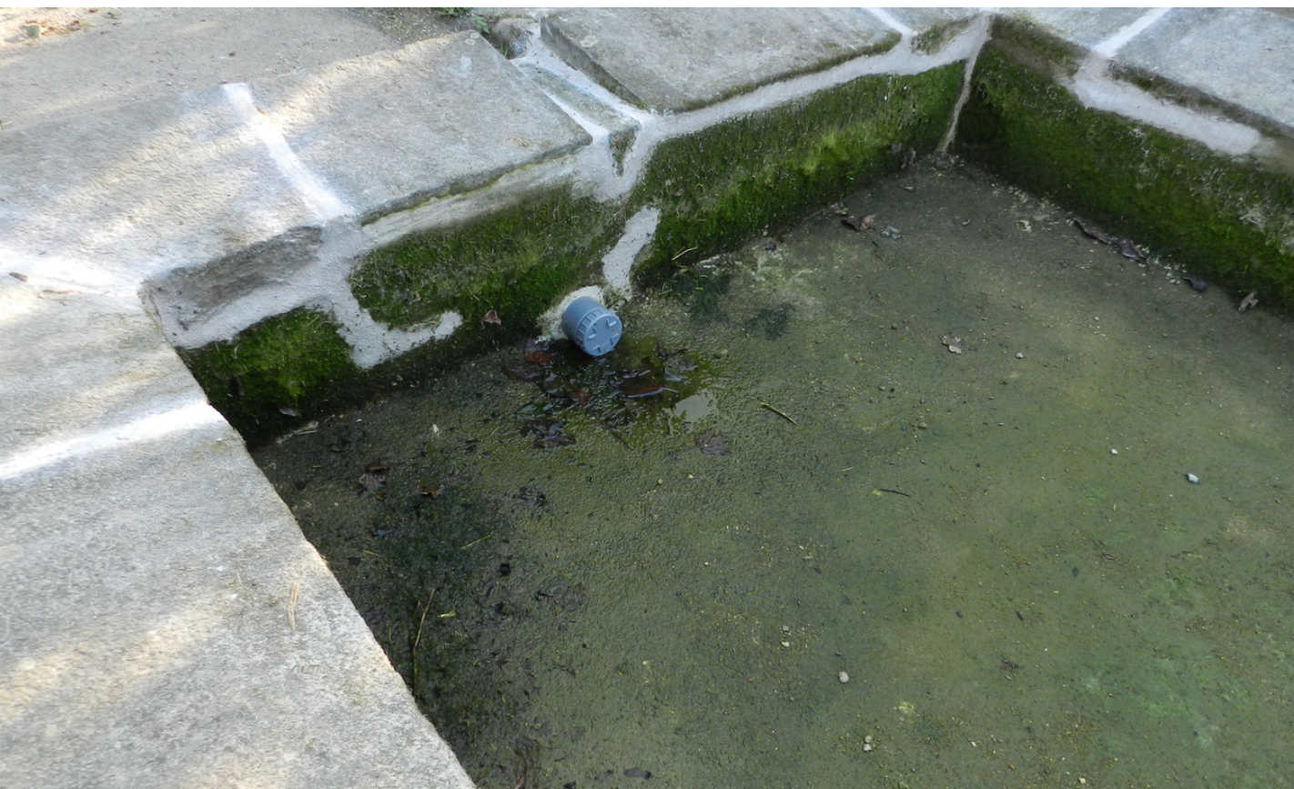
Pose d'une bonde de vidange munie d'une tête vissée © Lavoirs et fontaines à Plaintel
