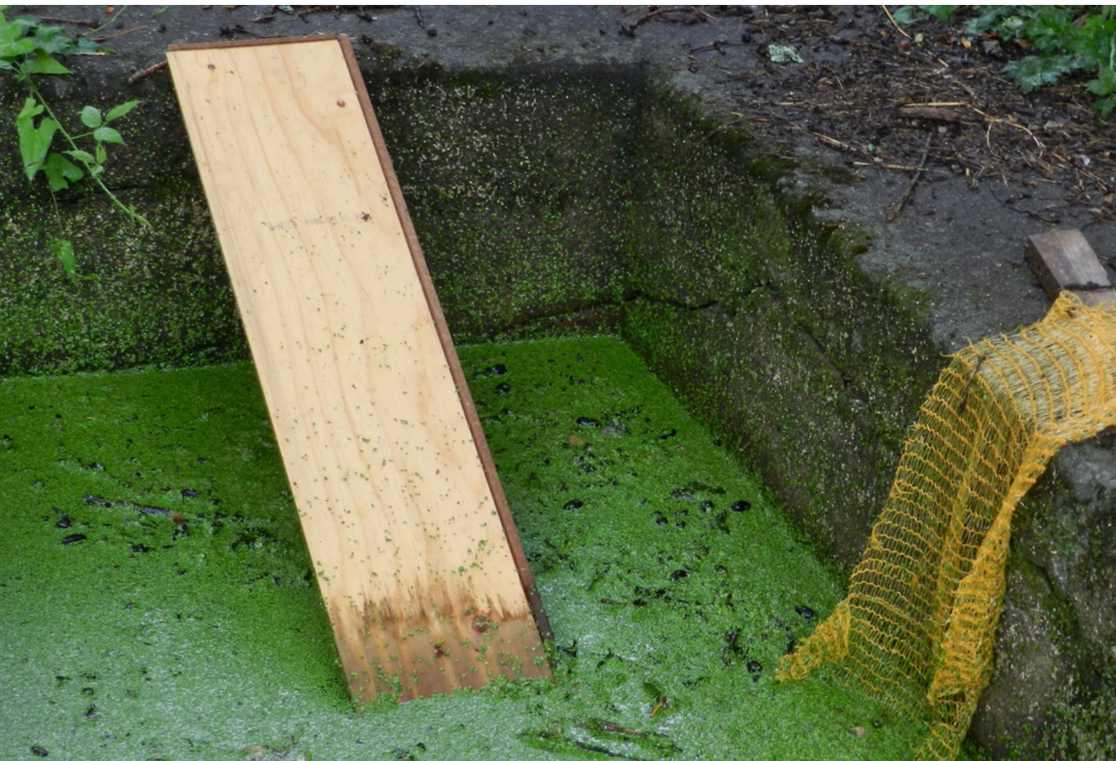
Planche et filet facilitant la sortie de la faune © Lavoirs et fontaines à Plaintel
