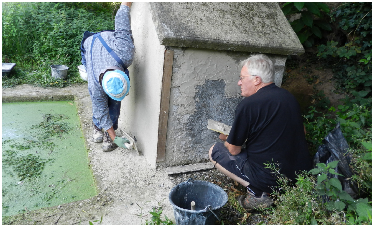
Recours à un mortier sable - chaux à l'extérieur du lavoir © Lavoirs et fontaines à Plaintel
