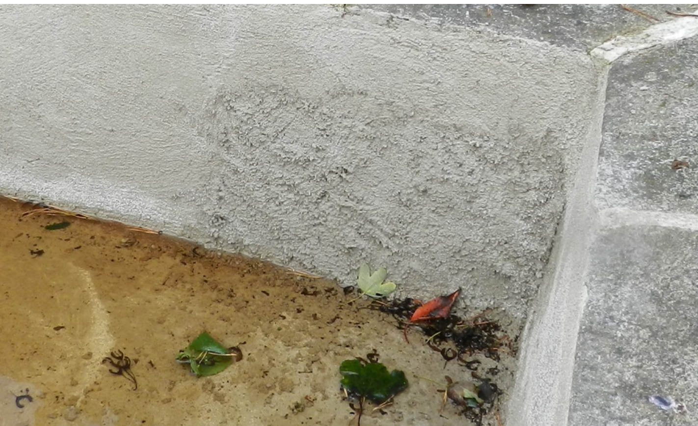
Pente douce et enduit gratté facilitant la sortie de la faune © Lavoires et fontaines à Plaintel
