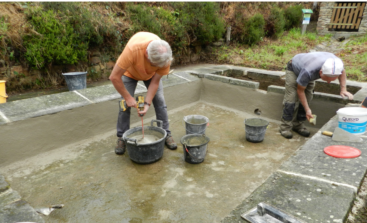
Recours à un mortier sable - ciment à l'intérieur du lavoir © Lavoirs et fontaines à Plaintel
