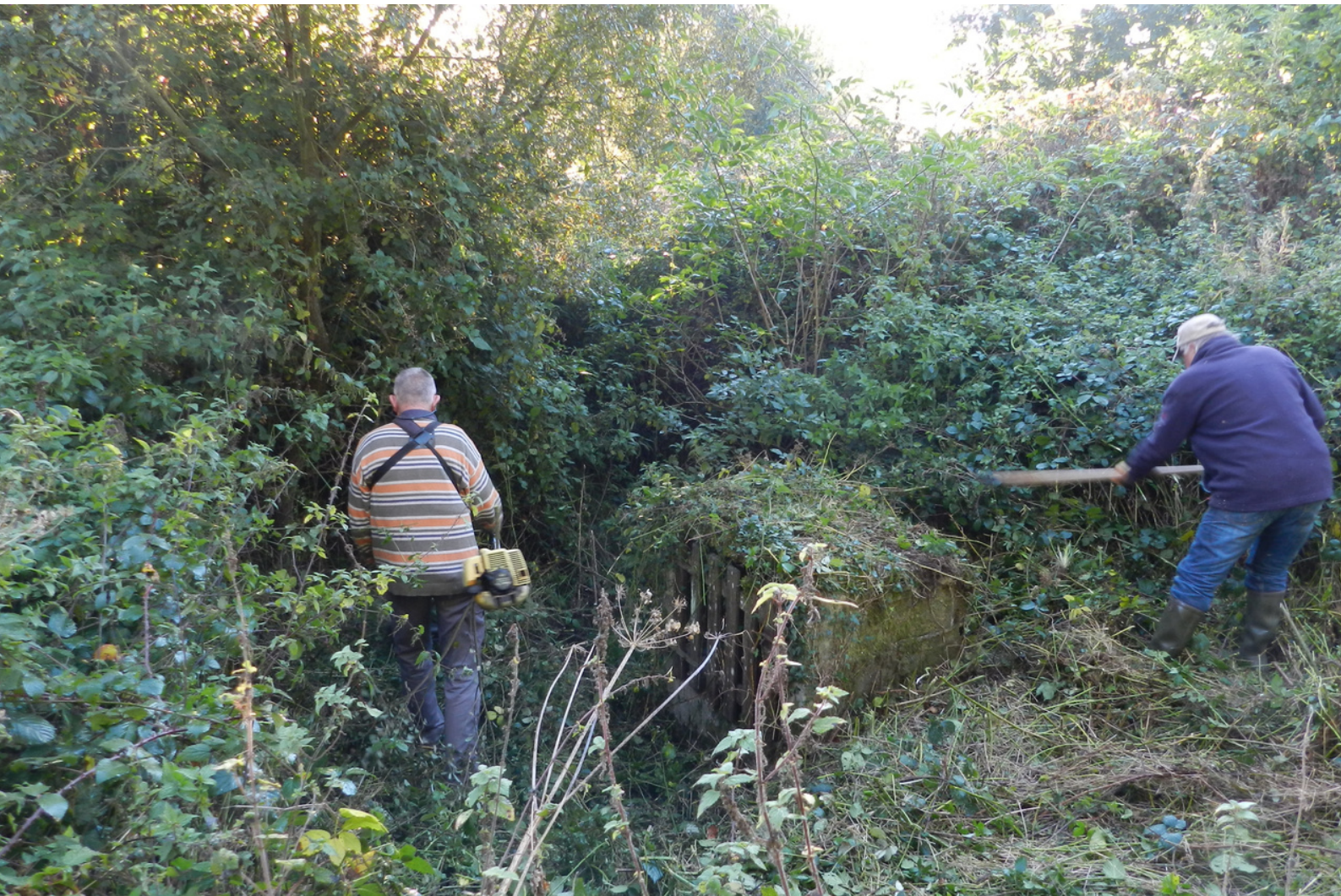
Débroussaillage avant travaux © Lavoirs et fontaines à Plaintel
