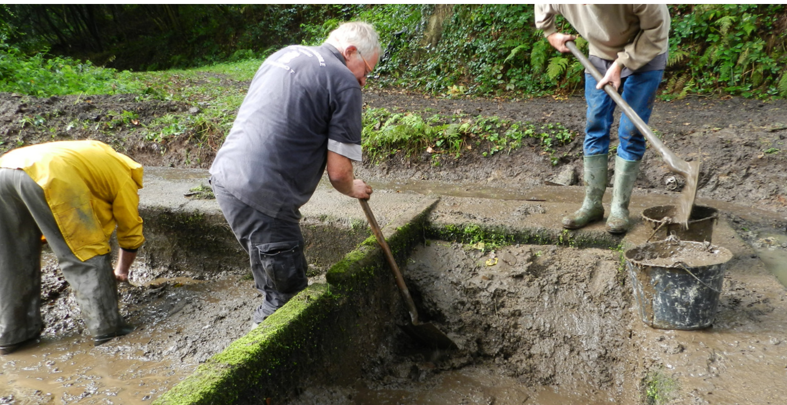
Curage de la boue de ravinement © Lavoires et fontaines à Plaintel
