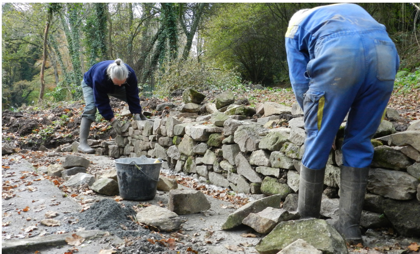
Construction d'un muret en pierre sèche © Lavoirs et fontaines à Plaintel
