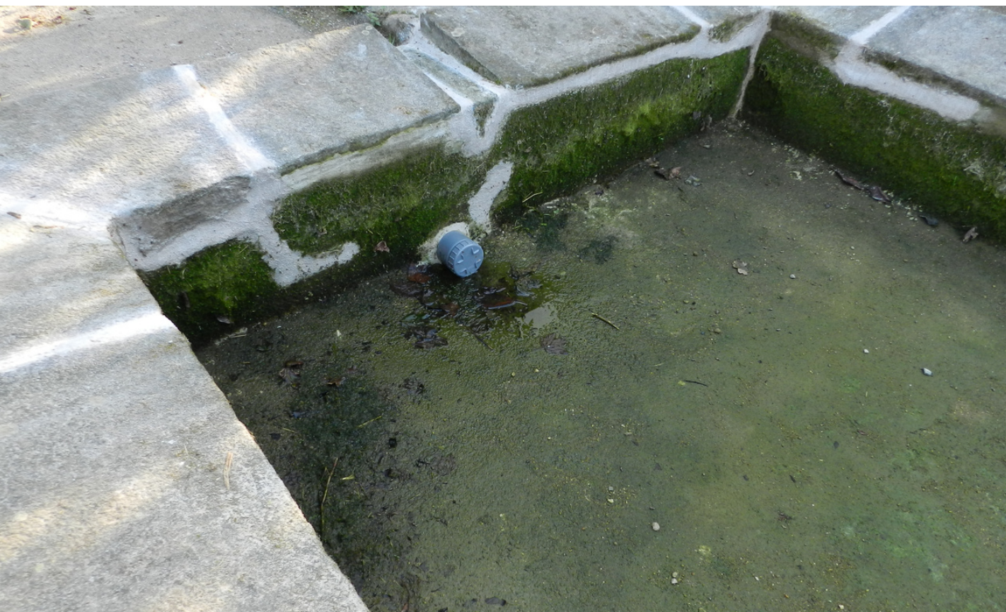
Pose d'une bonde de vidange munie d'une tête vissée © Lavoirs et fontaines à Plaintel
