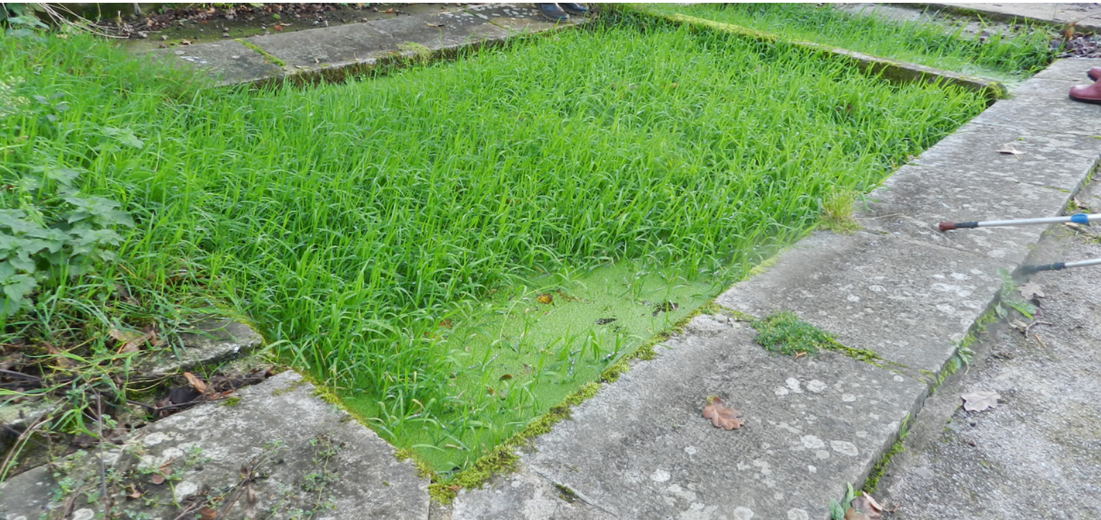
Agrostis stolonifère colonisant un bassin en novembre © Lavoires et fontaines à Plaintel
