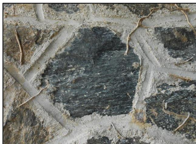
Fig. 61 : diorite gneissique de Morieux dans une pile du Viaduc des Ponts Neufs (photo 2018)
