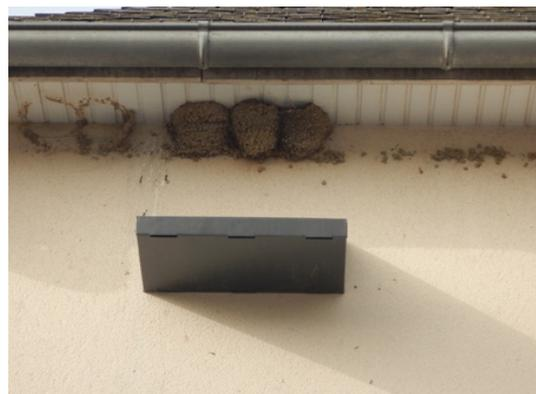
Dispositifs anti salissures installés sur des bâtiments communaux à Pluduno
