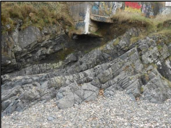
Fig.16 : Erosion de la falaise sous le blockhaus
