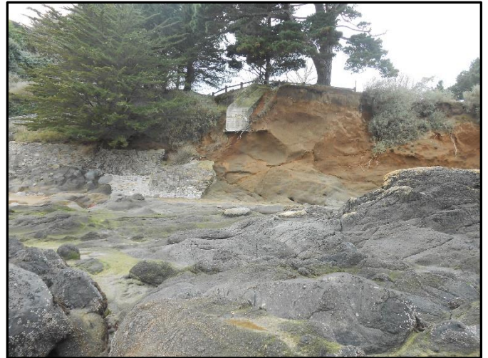
Fig.147 : Erosion de la diorite sous le blockhaus
