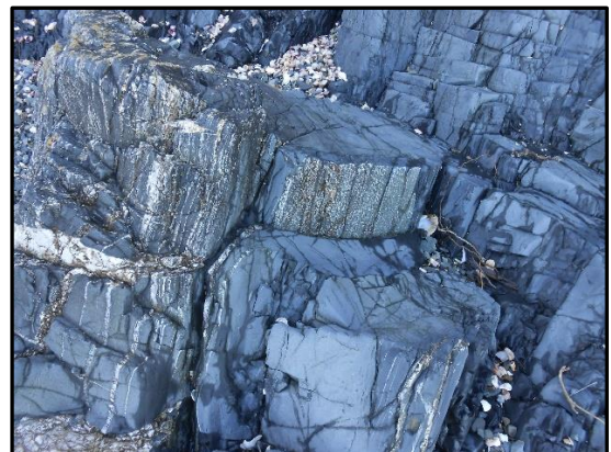
Fig.30 : Glissement banc sur banc avec stries siliceuses
