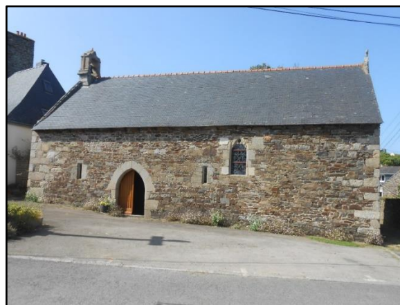
Fig.188 : Chapelle de Couvran (Plérin)
