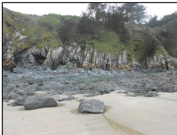
Fig.120 : Bancs de grès subverticaux
