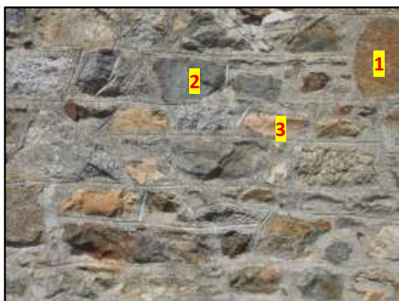
Fi g. 56 : Mur de la chapelle Saint-Lingast : 1 : Granodiorite de Saint-Brieuc (altérée); 2 : Métagabbro d'Yffiniac ; 3 : Grès éocène,
