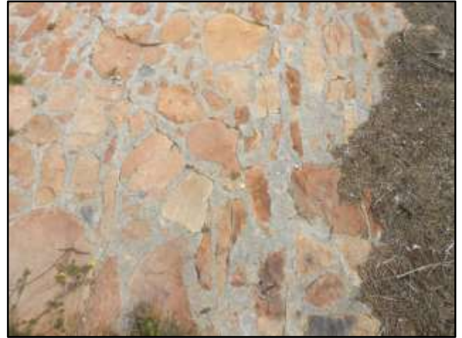
Fi g. 52 : Grès éocène sur une rampe d'accès à l'estran
