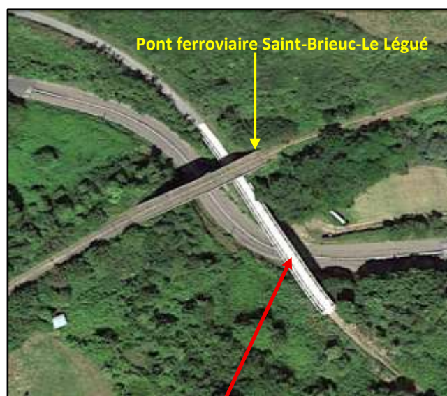
Fig.61 : Pont ferroviaire des Courses « Harel de La Noë » (photo satellite google Earth 2020)
