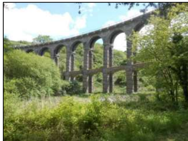
Fig.87 Viaduc « Harel de La Noë » de Douvenant
