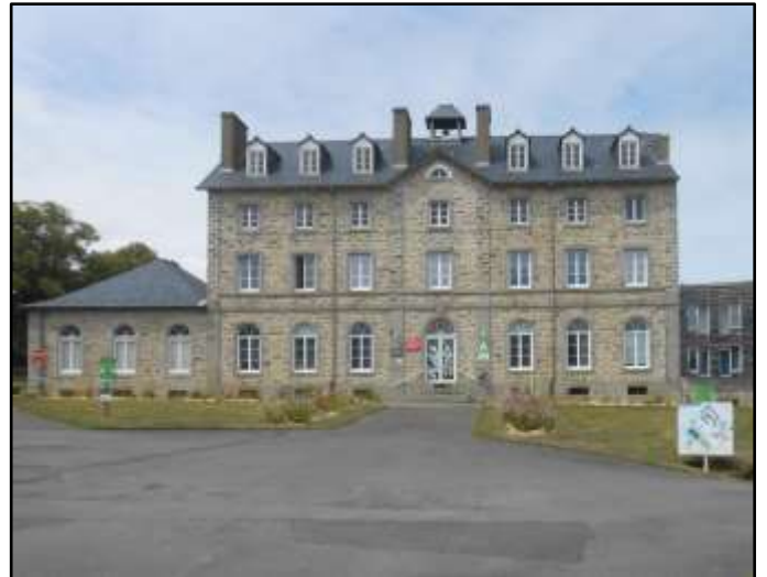
Fig.40 : Ecole de Saint-Ilan, bâtiment principal
