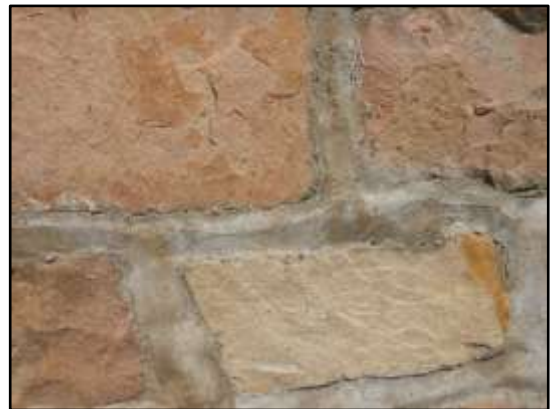
Fig.12 : Grès éocène sur une pile du Pont des Courses (7)
