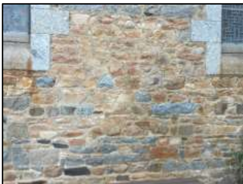
Fig.9 : Grès éocène sur le mur de l'église de Langueux (4)
