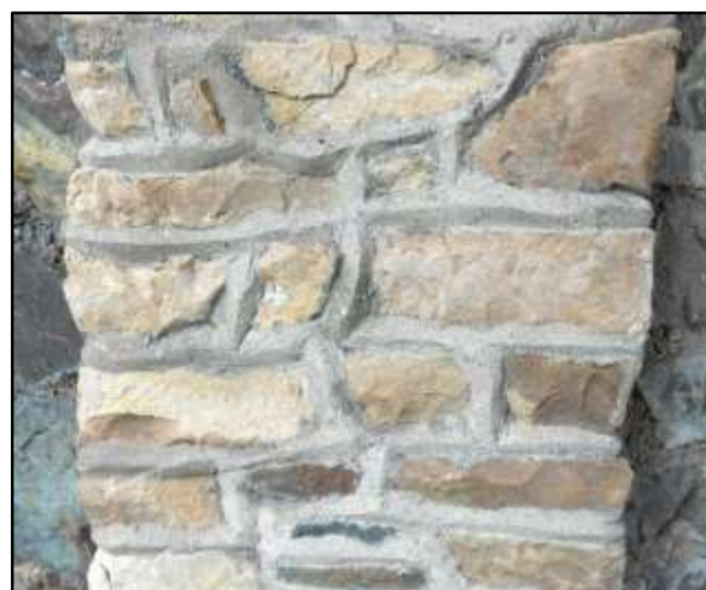
Fig. 64 : Blocs d grès éocène dans le Pont des Courses
