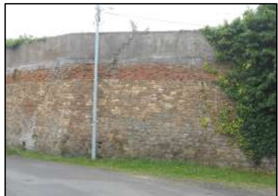
Fig.48 : Hétérogénéité verticale du mur d'enceinte
