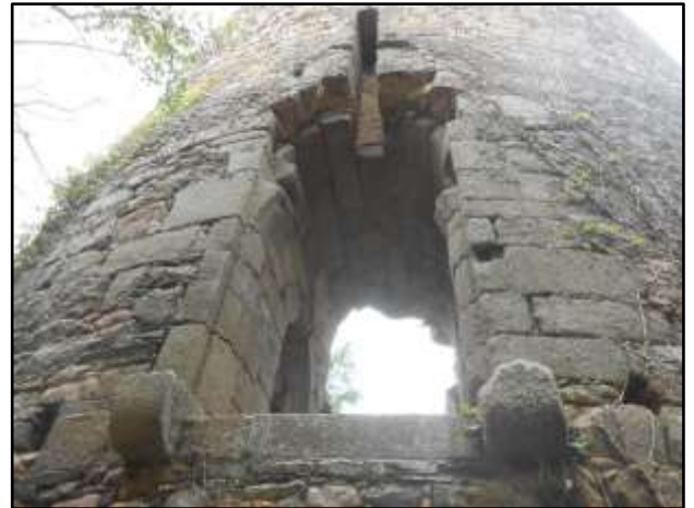
Fig.73 : Pierres taillées en granite de Languédias
