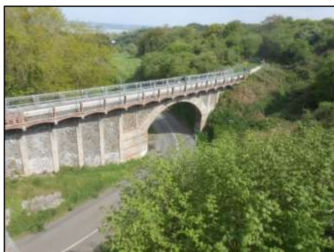
Fig.62 : Pont du chemin des courses « Harel de La Noë »
