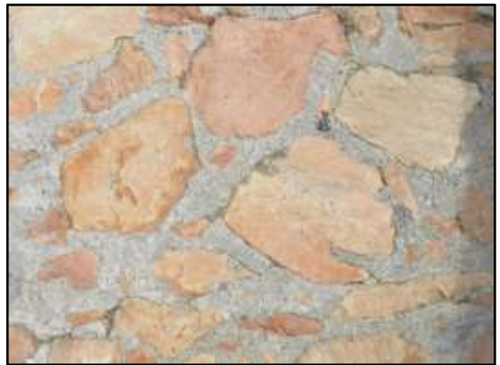
Fig.11 : Grès éocène dans la digue de la grève de Langueux (6)
