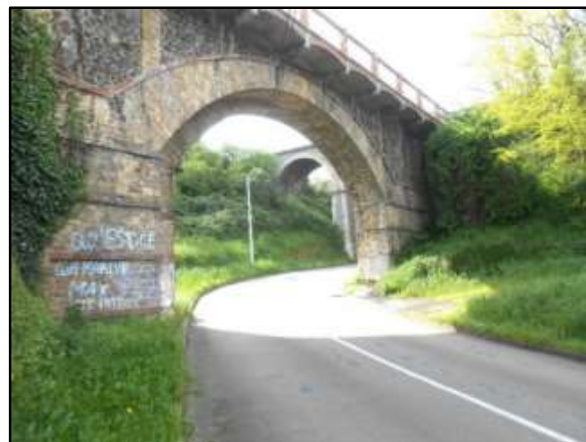
Fig.63 : Pont du chemin des Courses « Harel de La Noë »
