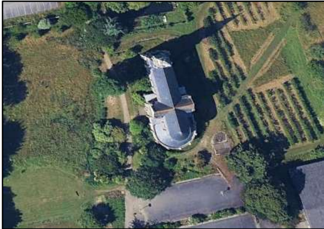
Fig.43 : Chapelle Saint-Léon (Photo satellite Google Earth 2024)
