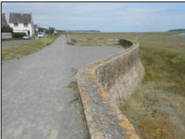
Fig.51 : Digue des Grèves, rampe d'accès à l'estran
