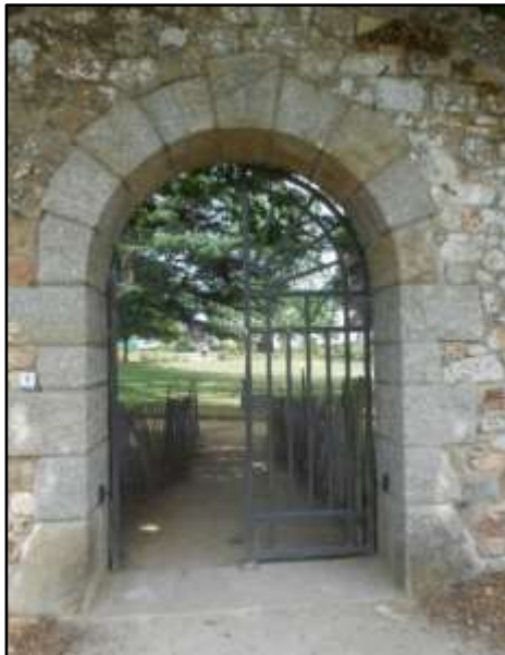
Fig.81 : Portail d'entrée du parc de Ty-Coat, rue Racine
