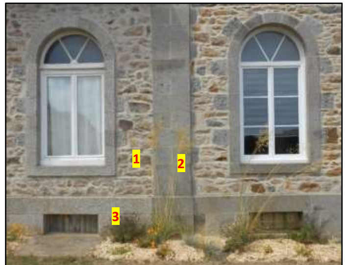
Fig.41 : Façade du bâtiment principal
