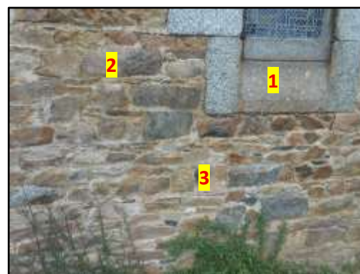
Fig. 59 : Mur de l'église de Languieux : 1 : Granite de Moncontour ; 2 : Granitoïde de Ploufragan ; 3 : Grès éocène
