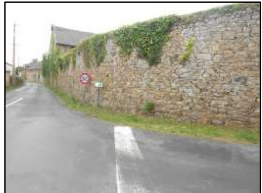
Fig.47 : Mur d'enceinte au nord, en grès éocène
