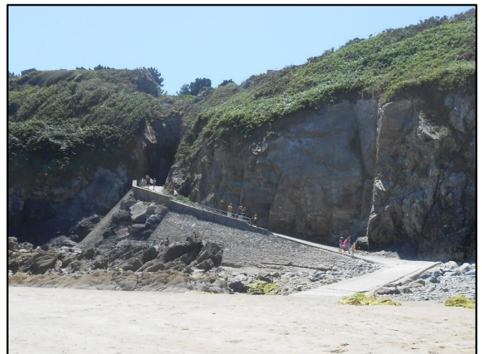
Fig.34: Rampe d'accès à la plage Bonaparte
