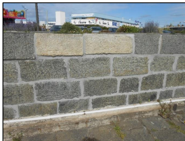
Fig. 97 : Mur en diorite de St -Quay et granite de l'île-Grande
