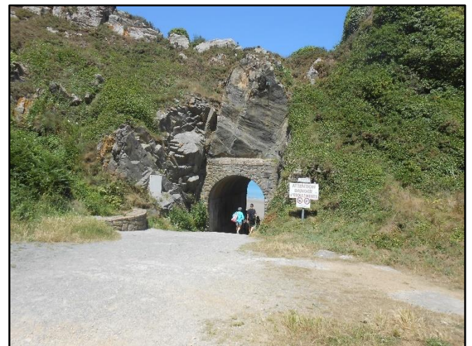
Fig.33: Accès à la plage Bonaparte, par le tunnel
