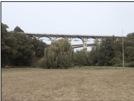
Fig. 140 :Point n°4 : Viaduc de Toupin, devant le viaduc RN12
