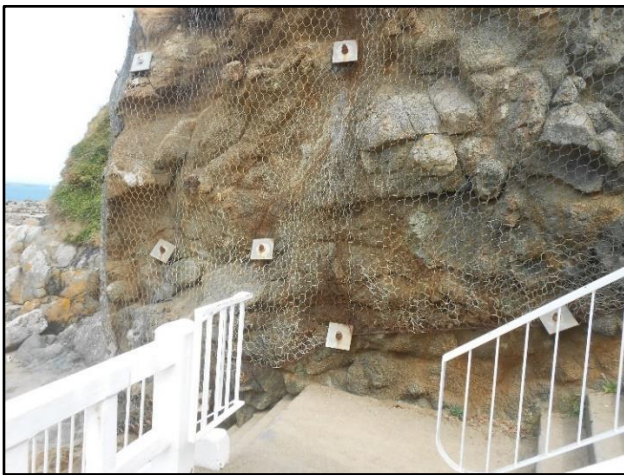
Fig.77 : Cloutage et pose de filets sur la falaise de diorite
