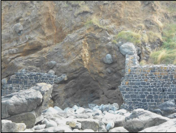
Fig.76 : Eboulement destructeur de la diorite altérée
