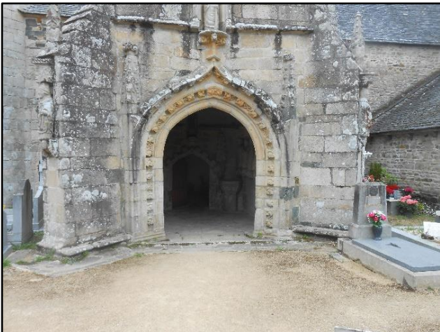
Fig.41 : Porche de l'église de Lanloup
