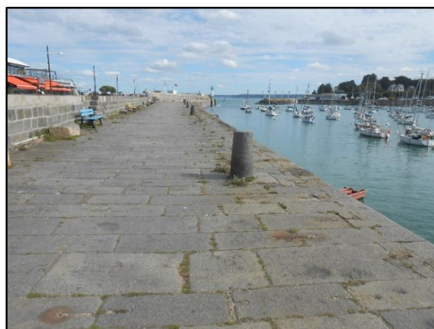
Fig. 96 : Utilisation de la diorite sur le port de Saint-Quay-Portrieux
