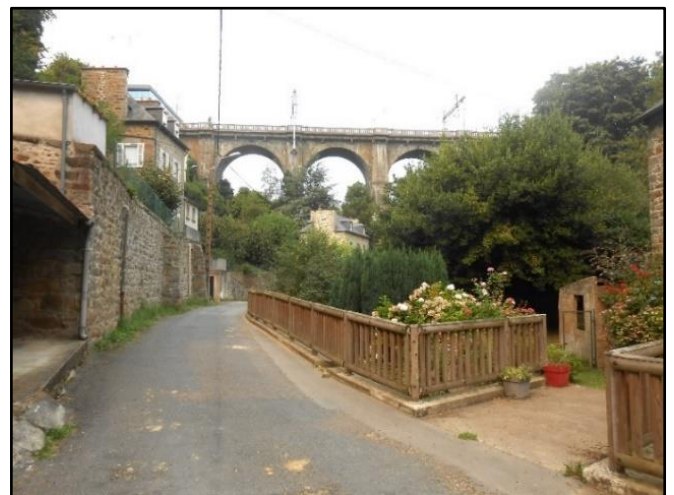
Fig. 154 : Point n°8 : Viaduc SNCF (vu de la rue des eaux minérales)
