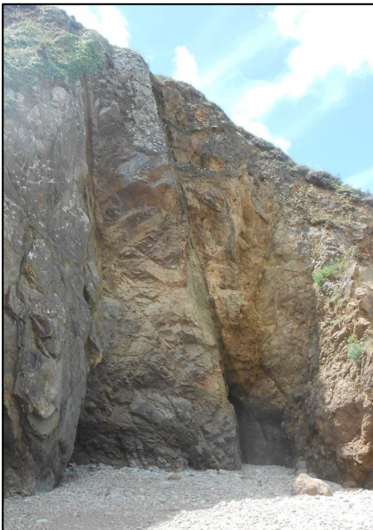
Fig.25 : Secteur fracturé (grève avant la Pte. du Pommier)
