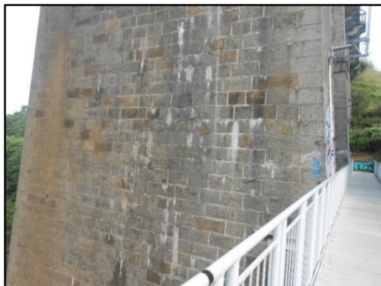
Fig. 155 : Point n°8 : Pile du Viaduc SNCF en granodiorite
