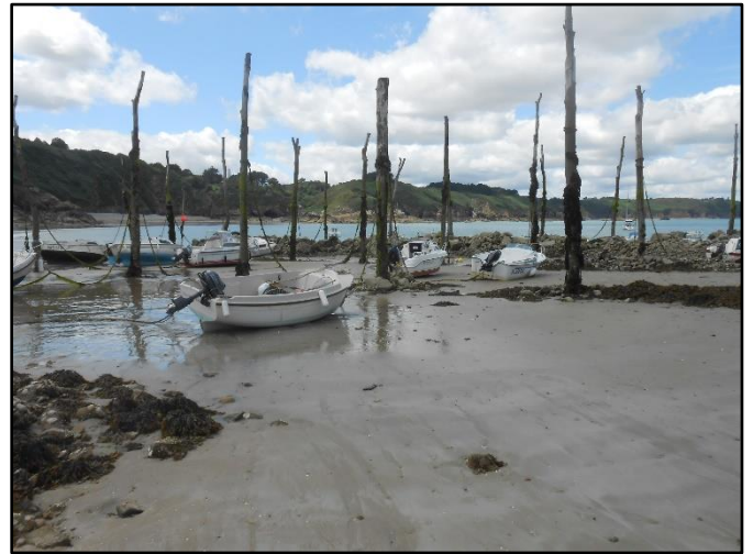
Fig.22 : Port à pieux de Gwin-Zegal
