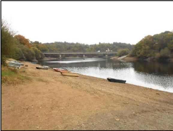
Fig.124 : Le Viaduc du Pont Noir en novembre 2024
