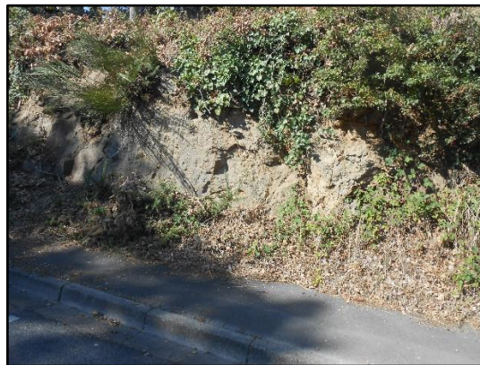
Fig. 159 : Point n°10 :Affleurement des granitoïdes, rue Paul Doumer
