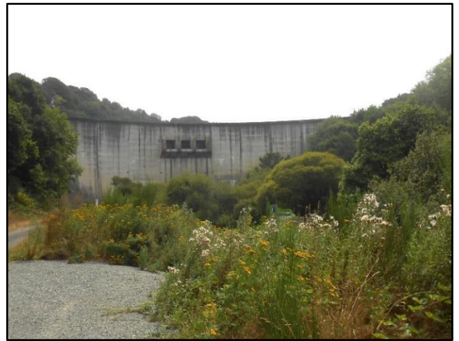
Fig.133 : Barrage sur le Gouet (aval)
