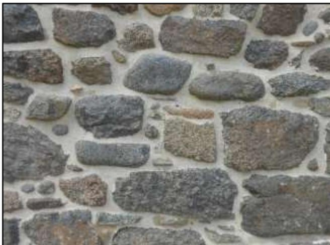
Fig.65 : Diorite en moellons et galets
