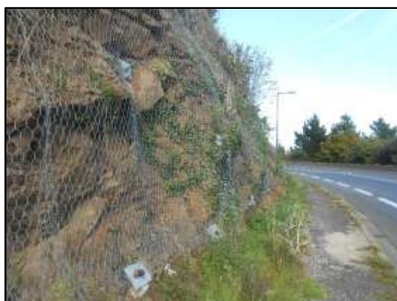
Fig.196 : Granodiorite de St-Brieuc altérée (et consolidée)
