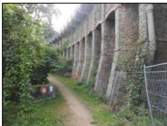
Fig.195 : Boulevard en encorbellement
