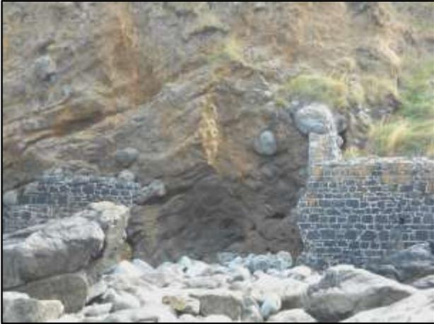
Fig.76 : Eboulement destructeur de la diorite altérée
