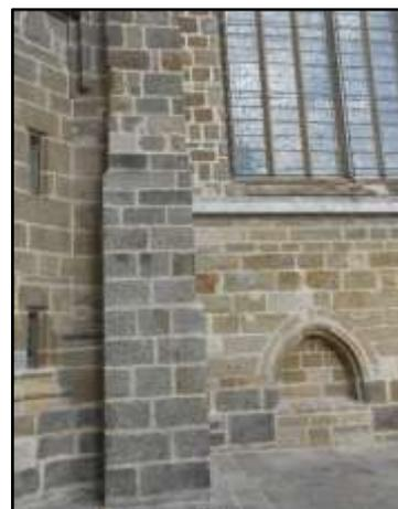
Fig.178 : Pilier en granodiorite (peu altérée)
