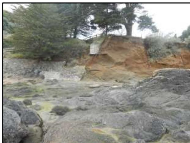
Fig.92 : Erosion de la diorite sous le blockhaus
