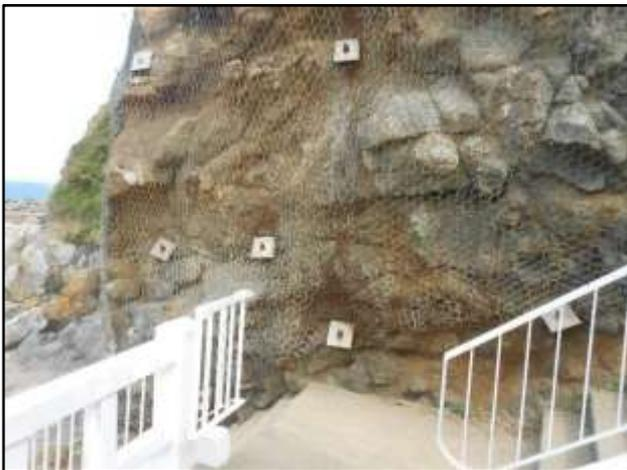
Fig.77 : Cloutage et pose de filets sur la falaise de diorite
