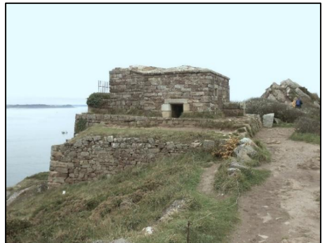
Fig.33 : Le Four à boulets (photo GM 2019)
