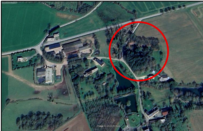
Fig26 : Ancienne carrière du Bas-Launay (photo satellite Google Earth 2025)
