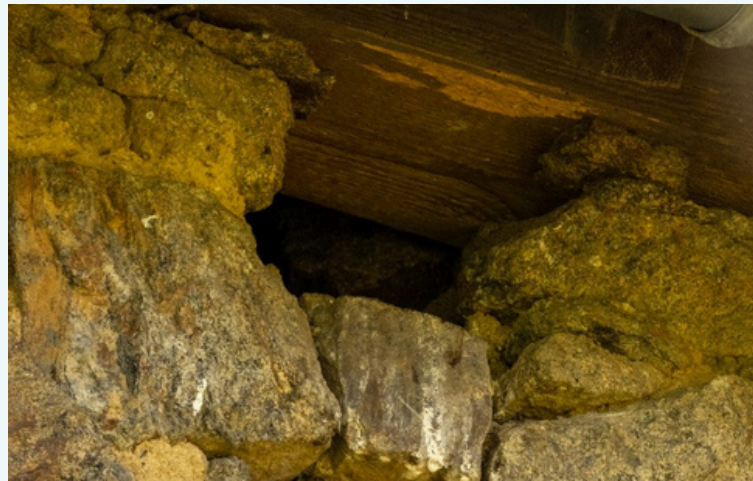
Cavité existante avant travaux © M. Bonneson
