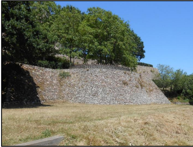
Fig.202 : :Murs en contrebas du château (GM2026)
