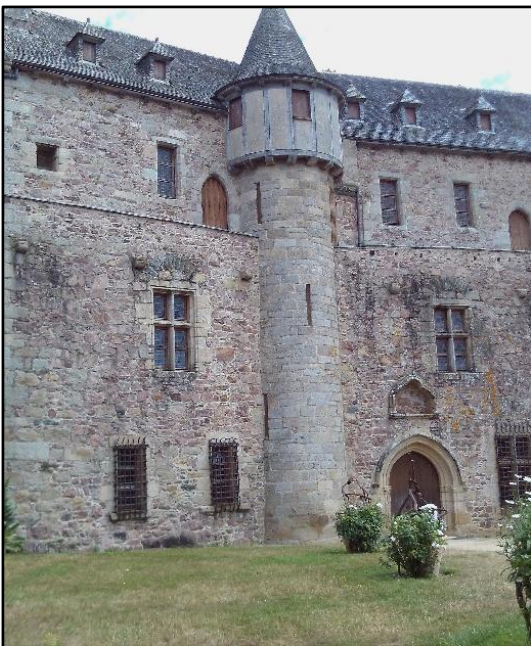
Fig.193 : Tourelle en façade (granite de Bréhat) (GM2026)
