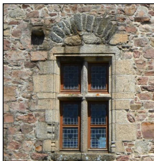
Fig.191 : Arc de décharge du linteau, en spilite, murs en grès rose, entourage en granite de Bréhat (GM 2019)
