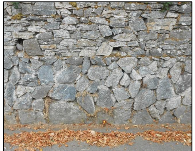
Fig.125 : Mur d'enceinte en amphibolite
