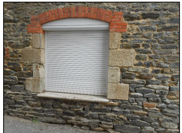
Fig.127 : Mur de maison en amphibolite
