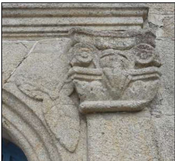
Fig.62 : Hôtel de Ville, détail de la porte, en granite fin
