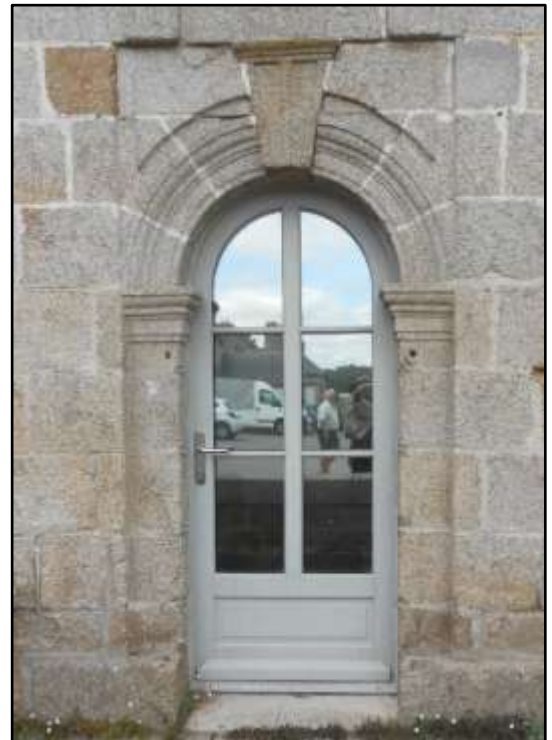
Fig.55 : Façade de l'ancien Office du tourisme
