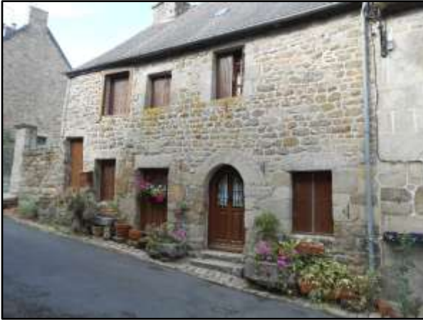
Fig.51 : Ancienne maison de la rue Saint-Michel
